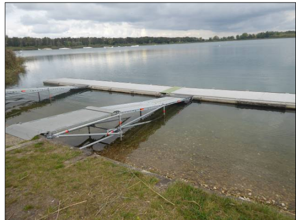
Abb. 15: Ponton am östlichen Uferbereich (Quelle: BK 2021)
