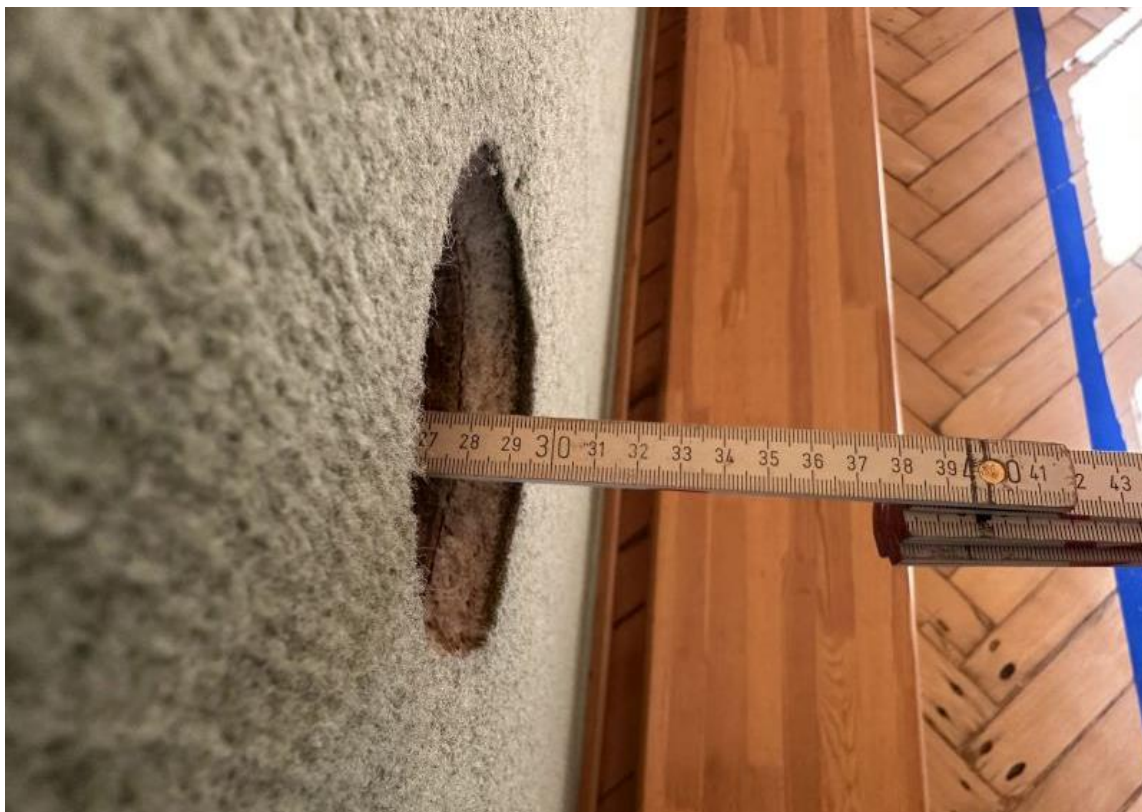
Bild 11: Unterkonstruktion der Prallwand Fensterwandseite im Bereich der Heizkörpernische
