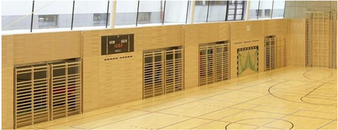
Beispiel Prallwandsystem mit integrierten Doppelfeld-Sprossenwänden
