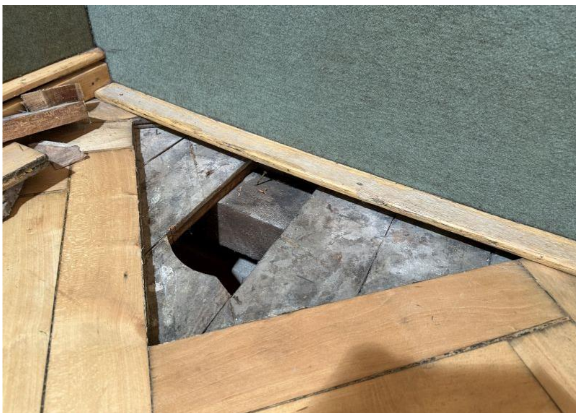
Bild 16: entfernter Parkettbelag (22 mm stark, Buche) und aufgesägte Holzdielung
