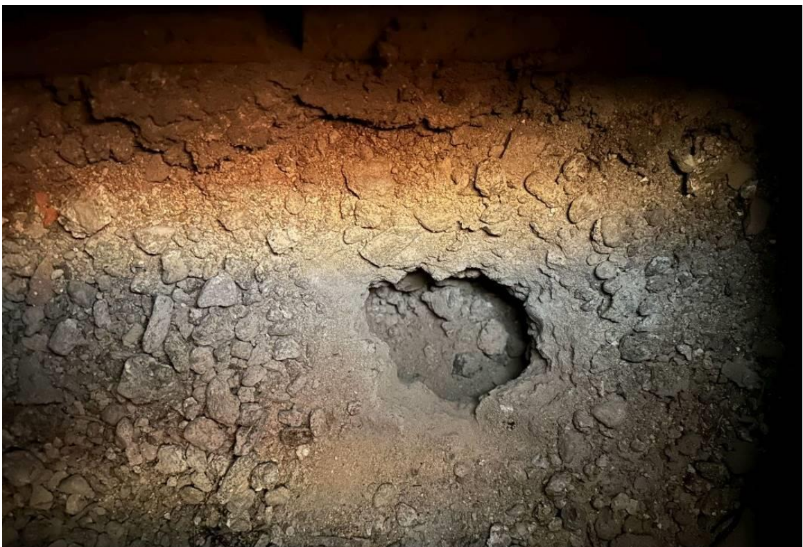
Bild 20: Blick auf die Magerbetonschicht, welche unter der Holzkonstruktion sich befindet
