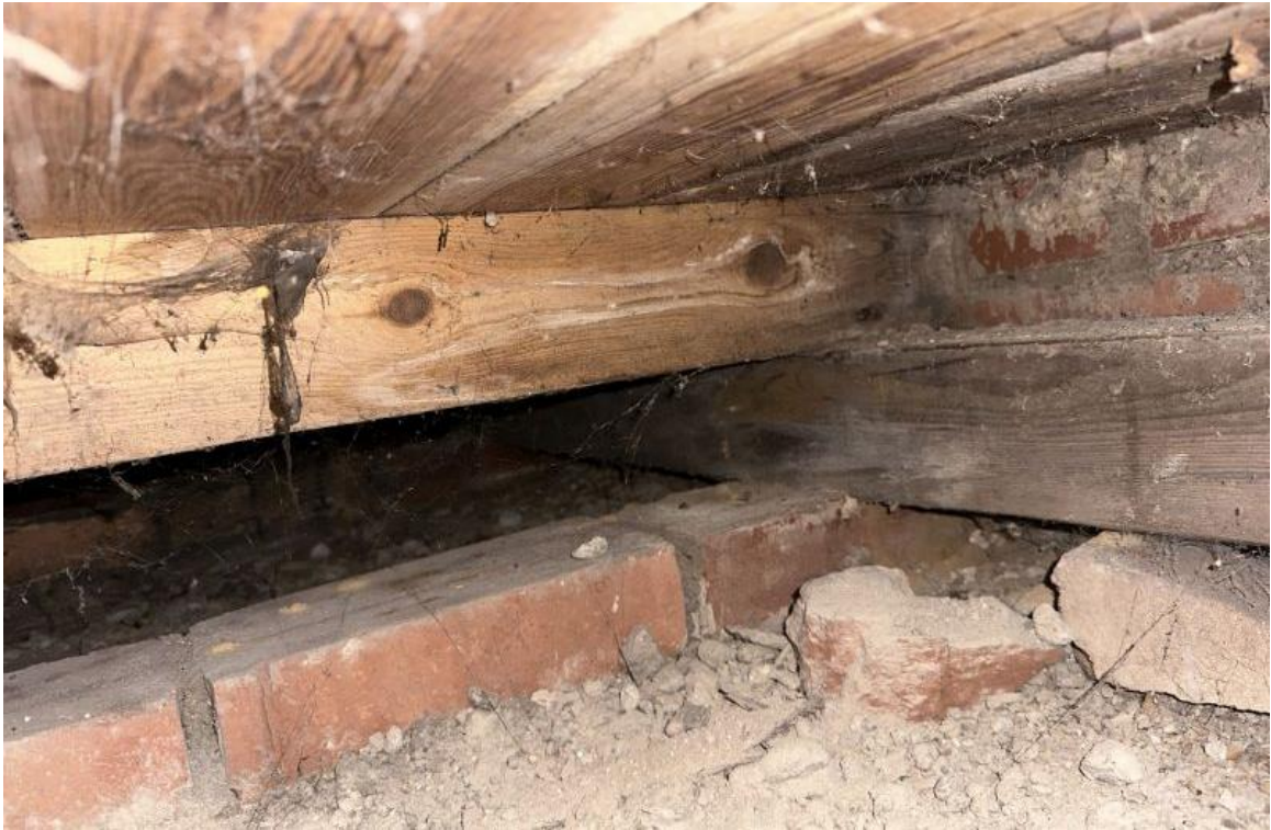
Bild 19: Blick auf die Ziegelwände, auf denen die unteren Balkenlagen aufliegen
