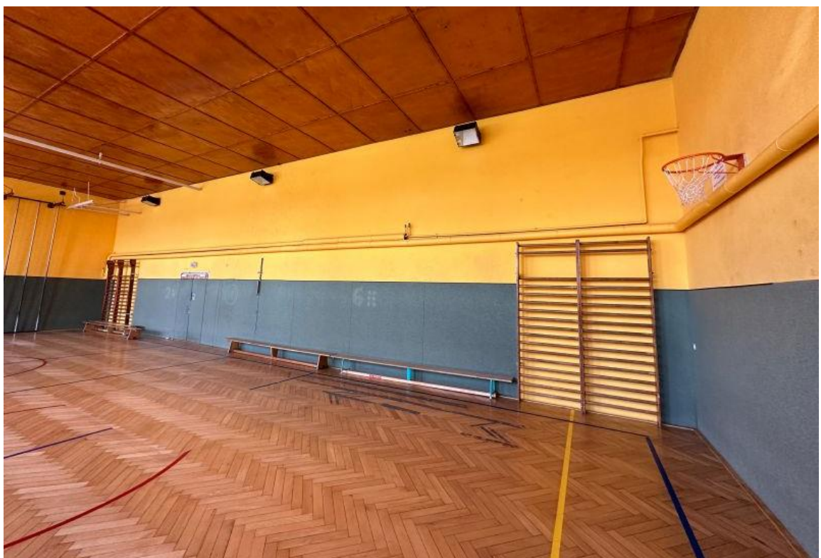
Bild 4: Ansicht Sporthalle mit Blick auf die Wand zum angrenzenden Schulhof
