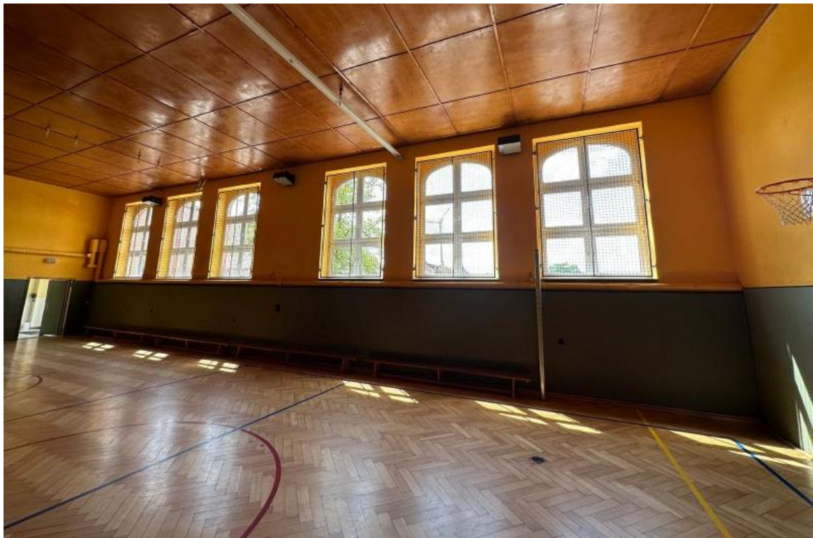
Bild 3: Ansicht Sporthalle mit Blick auf die Fensterwand
