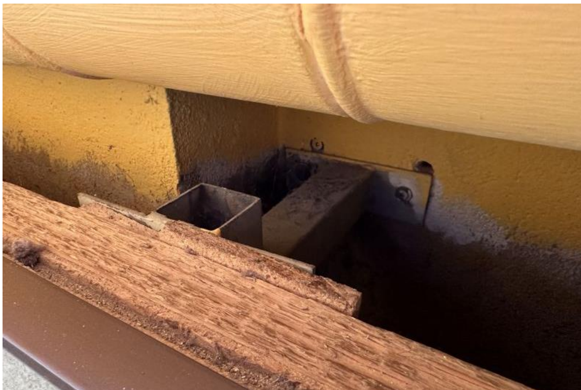
Bild 12: Unterkonstruktion der Prallwand Fensterwandseite im Bereich der Heizkörpernische
