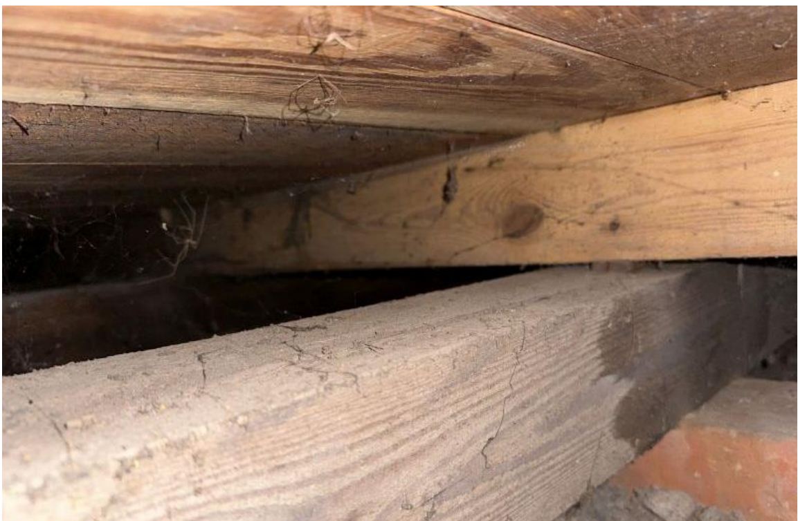
Bild 18: Blick in die Holzunterkonstruktion, bestehend aus einer oberen Balkenlage ( h/b=10/12 cm) und einer unteren Balkenlage ( h/b=10/12 cm), Achsabstand der Balken jeweils ca. 60 cm
