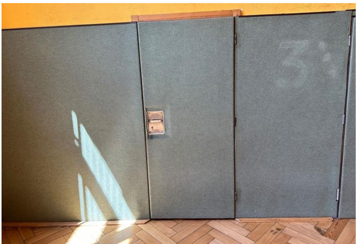
Bild 6: Ansicht Tür zum Hausmeister/Kleingeräteraum
