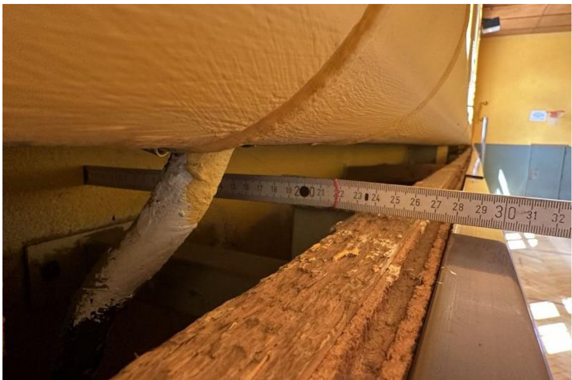
Bild 10: Prallwandkonstruktion Fensterwandseite, im Bereich der Heizkörpernischen
