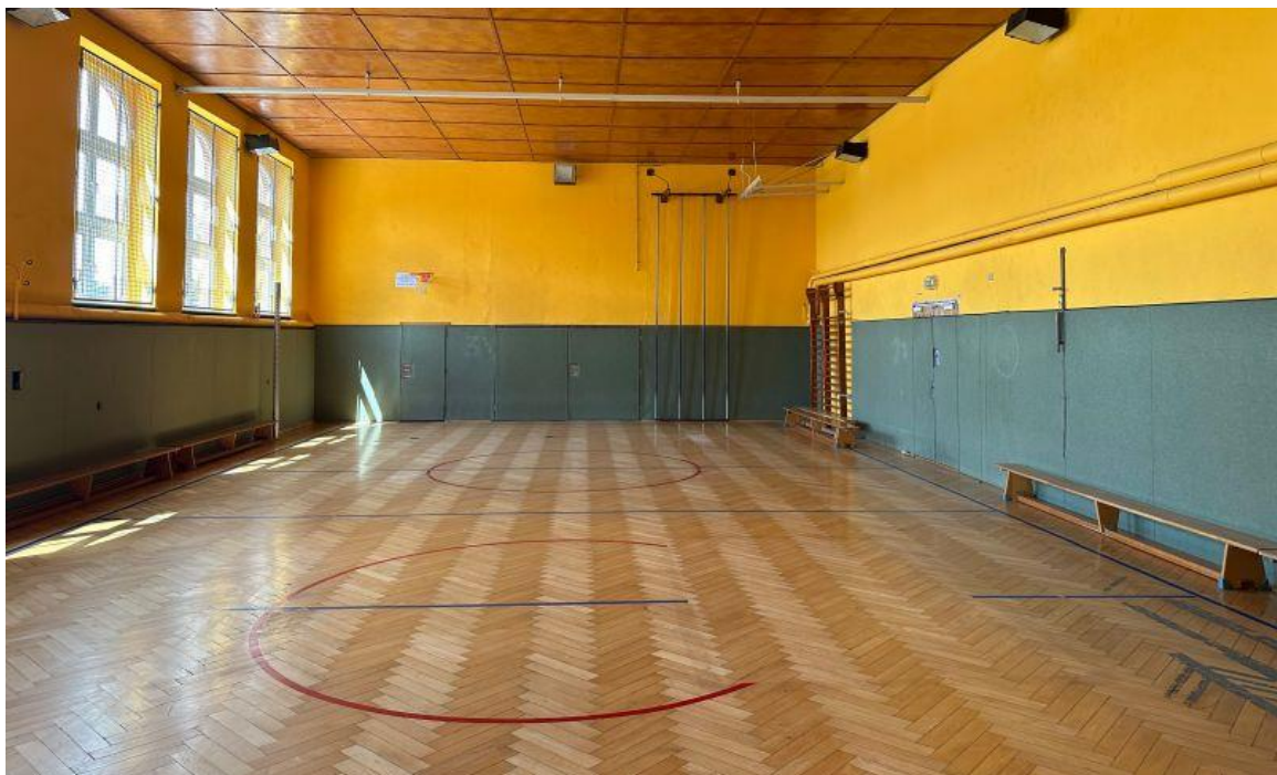
Bild 2: Ansicht Sporthalle mit Blick auf die Wand zu Hausmeister/Kleingeräteraum bzw. Sportgeräteraum
