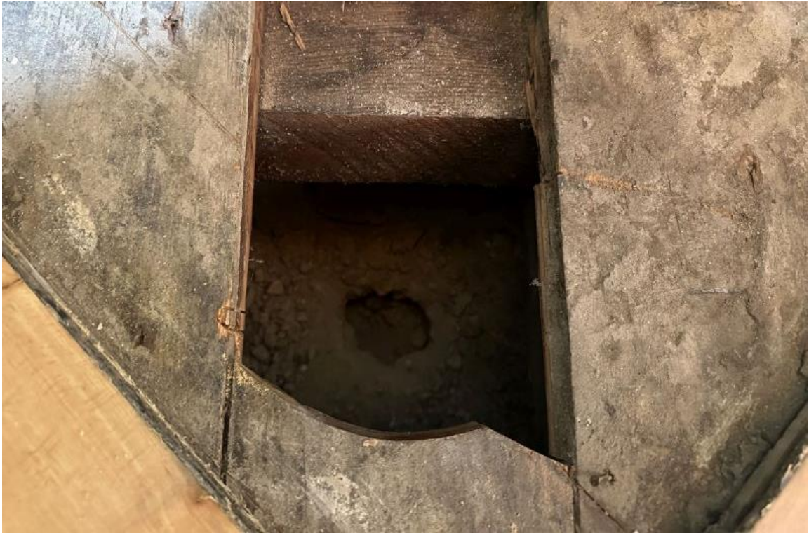
Bild 17: aufgesägte Öffnung durch die 30 mm starke Holzdielung (Lärche vernagelt)
