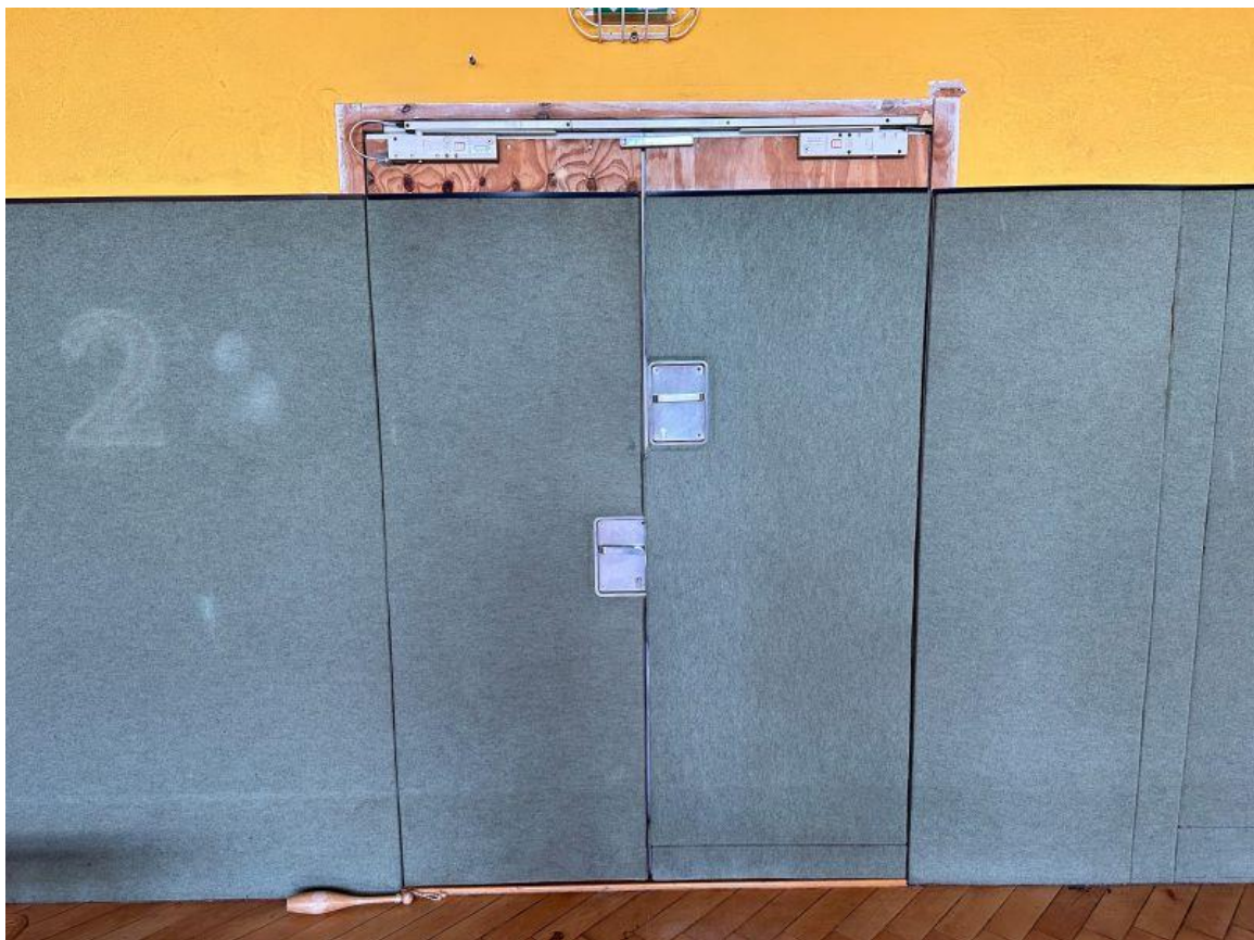
Bild 8: Fluchttür zum Schulhof
