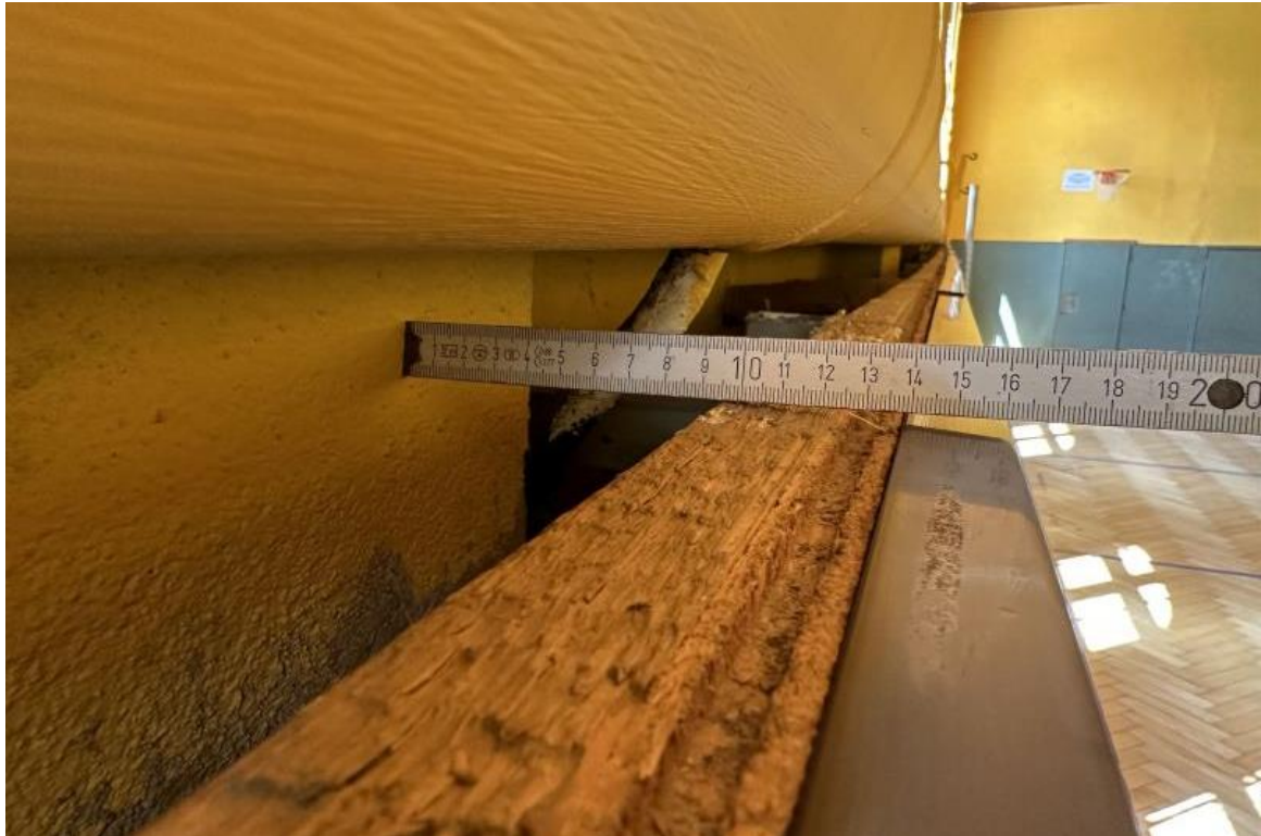
Bild 9: Prallwandkonstruktion Fensterwandseite, neben Heizkörpernischen
