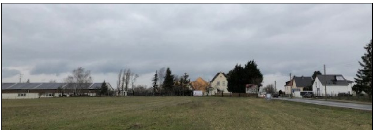
Abb. 10 Gewerbe- und Wohnflächen nördlich des Plangebiets (Blickrichtung Norden) Foto: 07/2023
