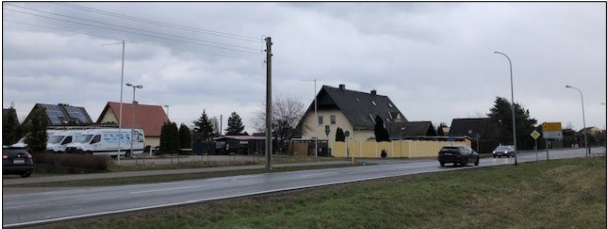
Abb. 11 S 11/Dübener Landstraße mit angrenzender Gewerbe- und Wohnnutzung, Freileitung und Straßenbeleuchtung östlich des Plangebiets (Blickrichtung Südosten) Foto: 07/2023
