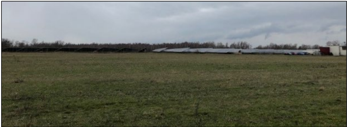
Abb. 9 PV-FFA im Bestand (Blickrichtung Westen); Foto: 07/2023
