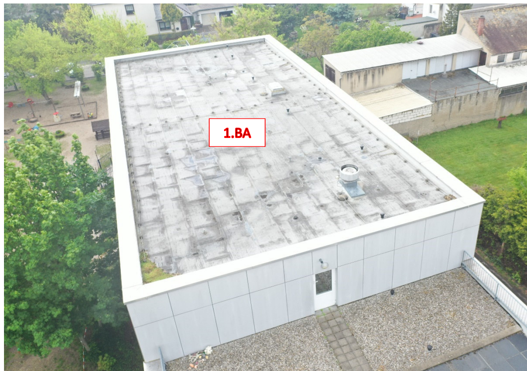
Dachfläche über 2. Obergeschoß (1. Bauabschnitt)
