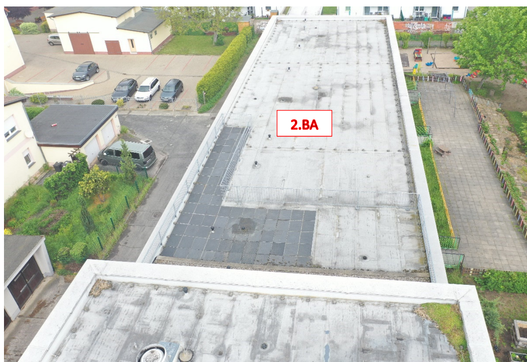
Dachfläche über 1. Obergeschoß (2. Bauabschnitt)
