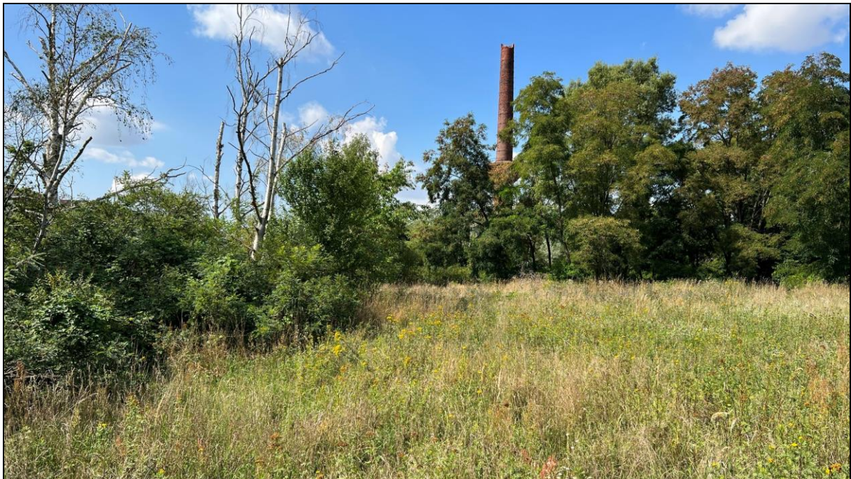
Abbildung 5 Bereich KRB 12, ehem. Aschespülhalde (OFW I), Blickrichtung West
