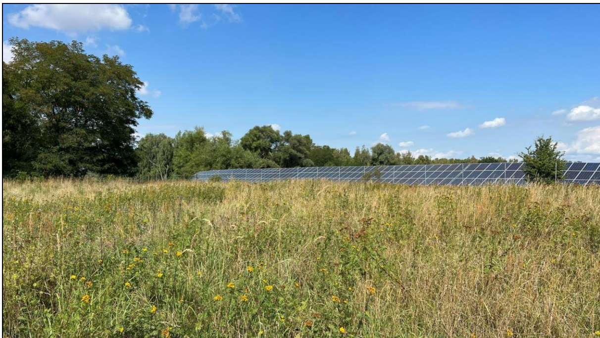
Abbildung 4 Bereich KRB 12, ehem. Aschespülhalde (OFW I), Blickrichtung Nord
