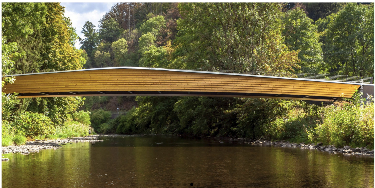
Abb. 3 Ersatzneubau als Trogbrücke (Beispiel)
