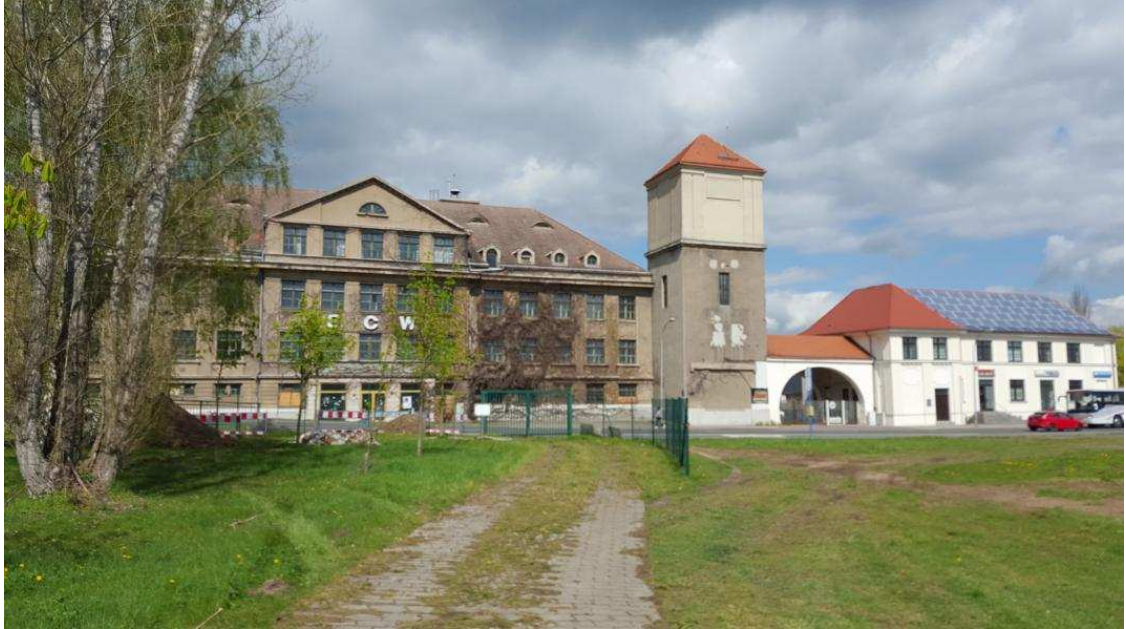
Bild 2: Nordwestspitze (Tankstelle geplant) Blick von Süd nach Nord
